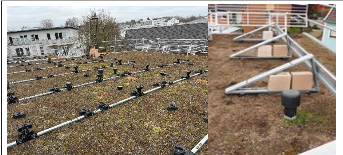
Die ersten Schritte: Die Schuhe mit den Steinbeschwerden sowie die Aufständungen werden angebracht und untereinander verbunden.
