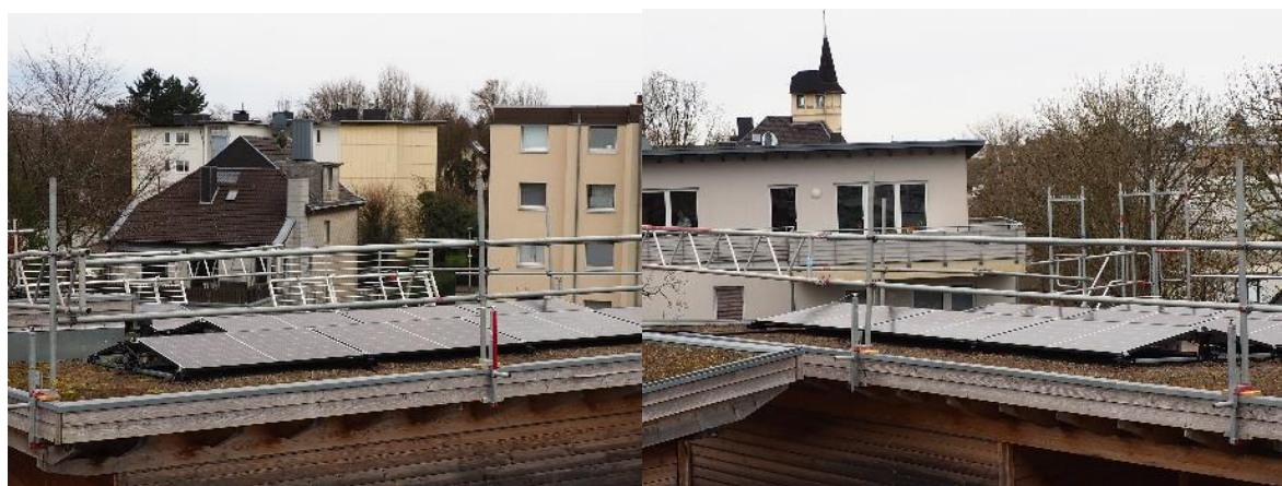
Nach und nach folgt die Installation der PV-Module
